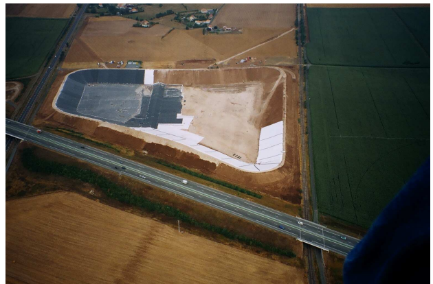
Retenue de substitution en construction (Poitou Charente – ©JJ. Guillet.)
