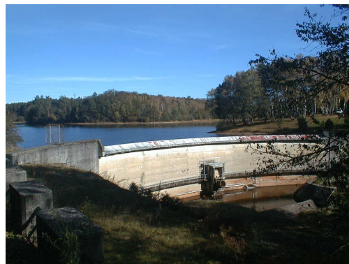
Barrage sur la Glane (Haute-Vienne – ©J. de Lespinay)
